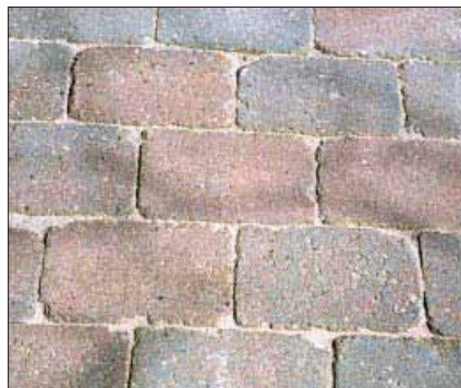
Fugerne skal efterfyldes hvis der mangler fugegrus. Der skal benyttes korrekt fugegrus 5 .
