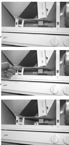
Bypass spjæld i vinter position
